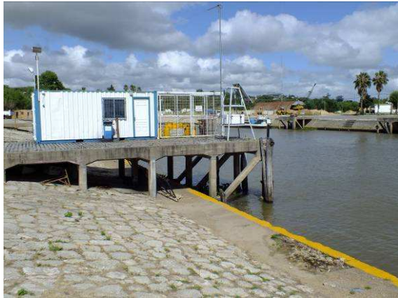
Taller para atención de autoelevadores y depósito de garrafas
