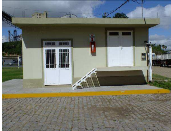
Sala control de imágenes
