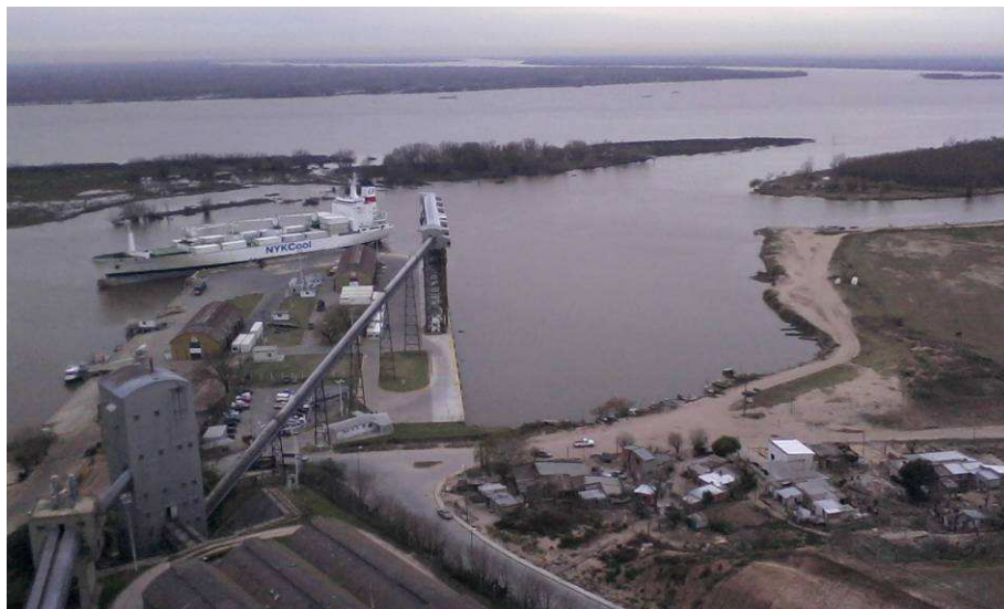
Puerto en operatoria de carga en paletizada en el Muelle Cabecera
